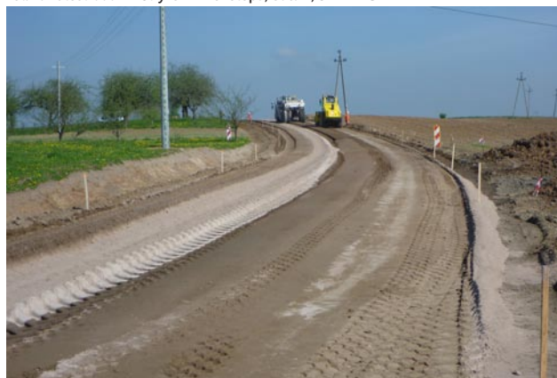
Fot. 2. Droga wiejska Reszki – Łabętnik, STRABAG
