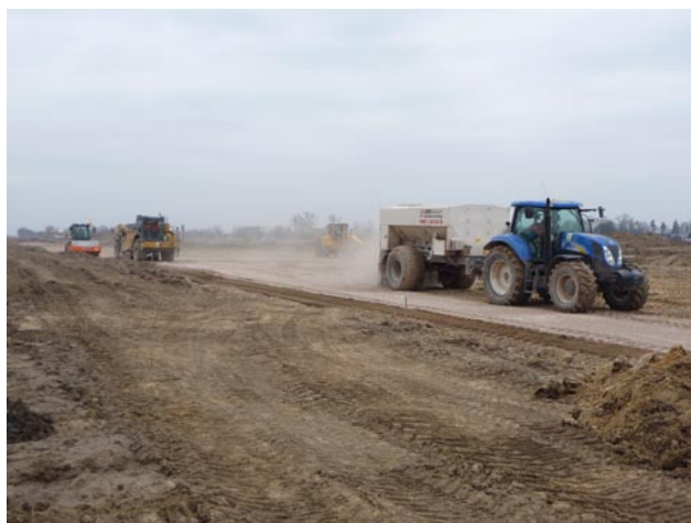
Fot. 1. Autostrada A2 Stryków – Konotopa, odc. D, STRABAG
