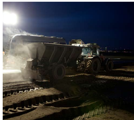
Stabilizacja gruntu za pomocą recyklera
