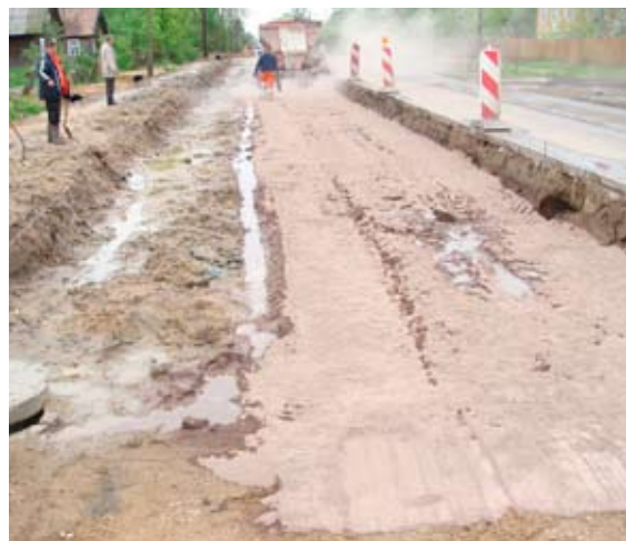
Budowa drogi lokalnej Zambrów
