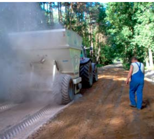
Stabilizacja drogi leśnej w miejscowości Piaski
