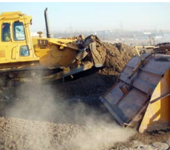
Platforma pod parking i drogi w Czeladzi, stabilizacja spoiwem hydraulicznym
