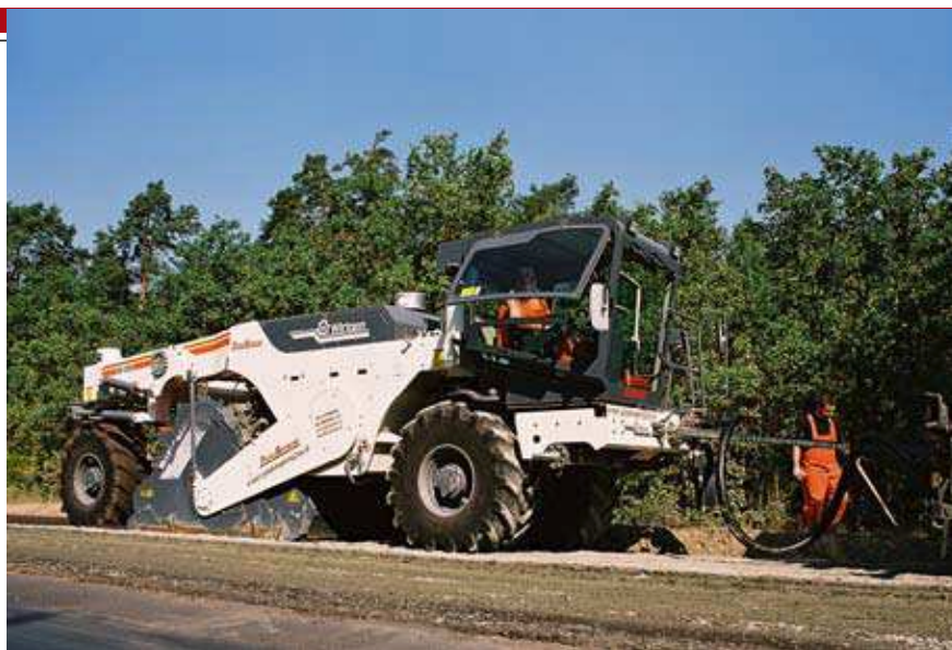
Recykler WR 2000 w trakcie wykonywania podatnej podbudowy MCE
