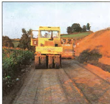
Fot. 1. Zagęszczanie warstwy nasypu drogi dojazdowej po wykonanej stabilizacji
