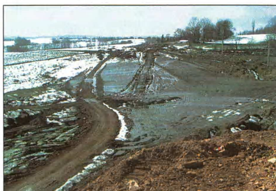
Fot. 2. Konstrukcja nasypu w okresie wczesnowiosennym. Widoczna droga technologiczna (lewa strona fotografii) po wykonanej stabilizacji
